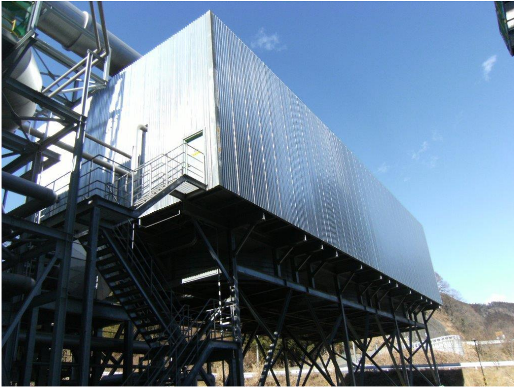
写真 9-3-1(5) 防音パネル (蒸気復水器)
