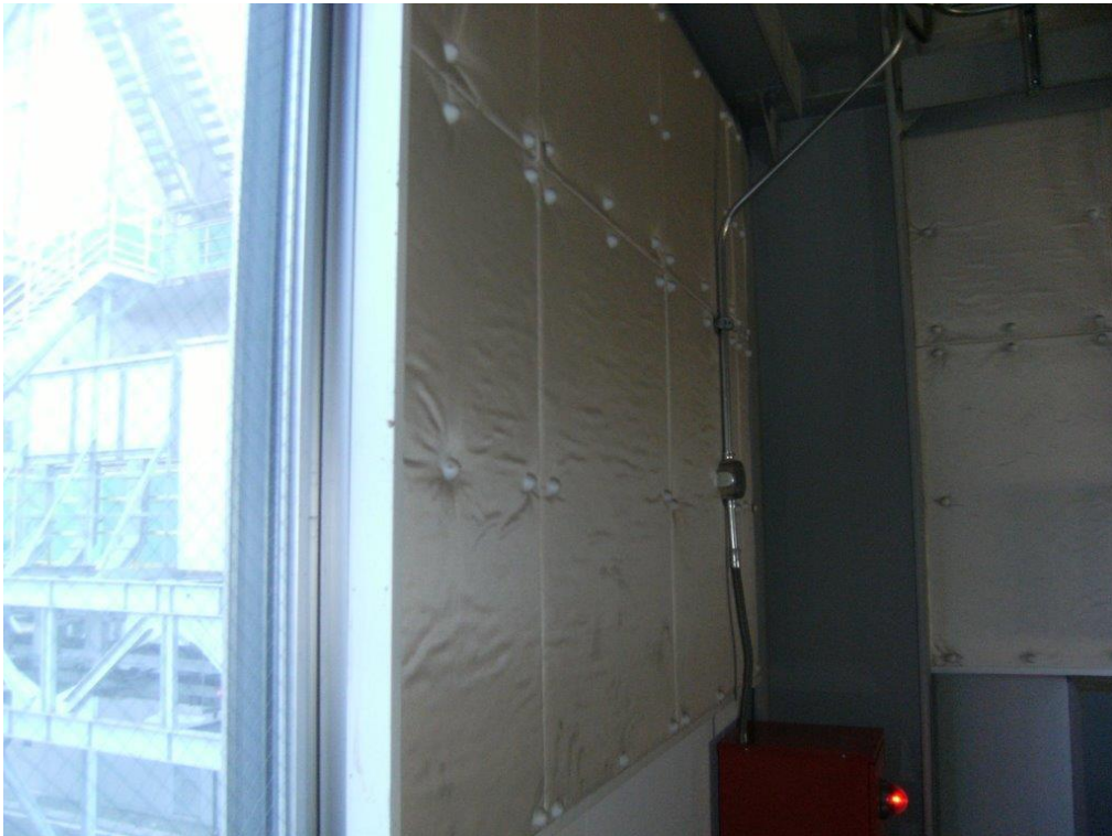
写真 9-3-1(4) 吸音材 (蒸気発電タービン室内)
