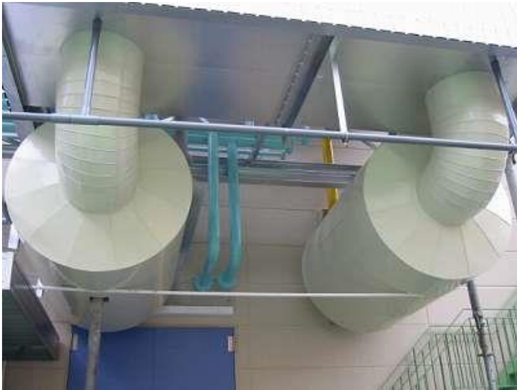
写真 9-3-1(2) ラギング (配管部)
