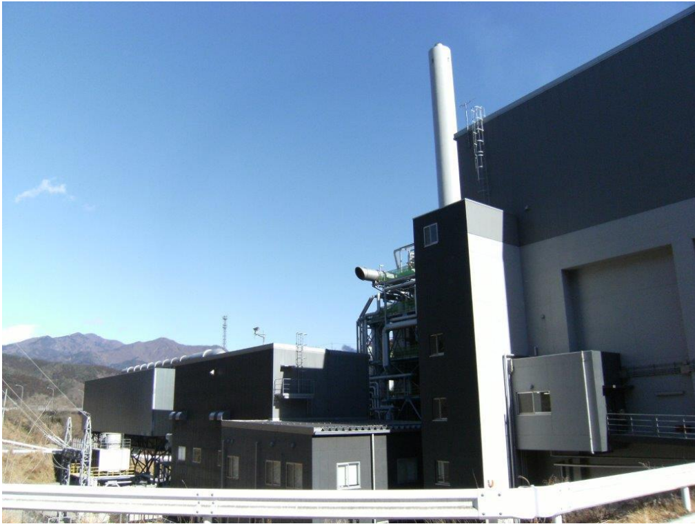
写真 9-3-1(1) サイレンサー (写真中心部の円筒部分)
