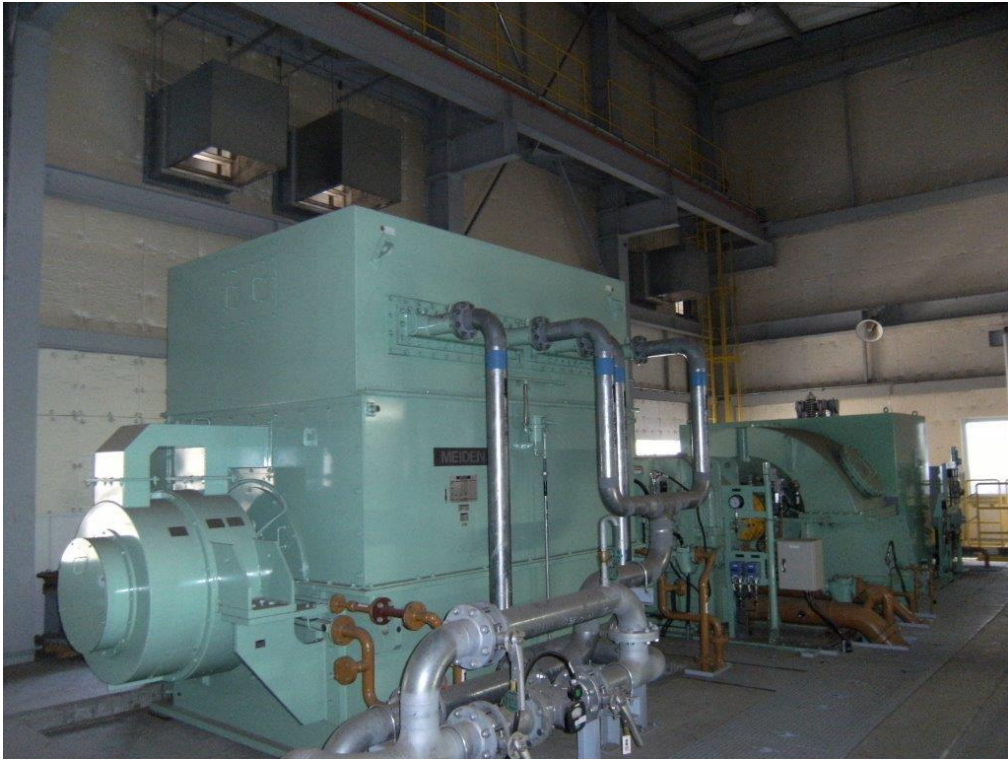
写真 9-3-1(3) 防音ボックス (発電タービン部)
