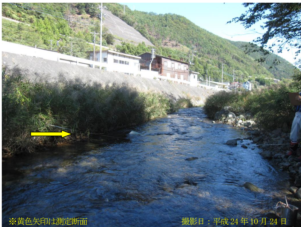
写真9-7-1(3) A3 測定地点（上流から下流に向けて撮影）
