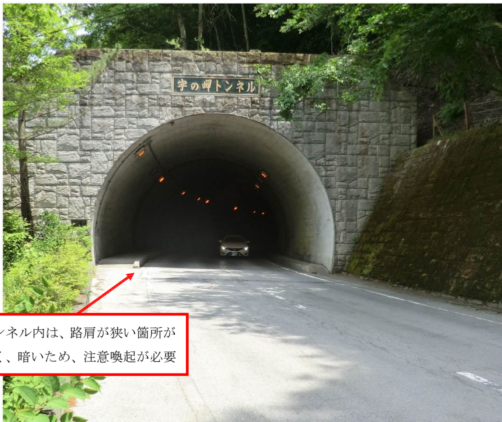
図- 4.7 自転車利用者から見たトンネル入口付近の様子
