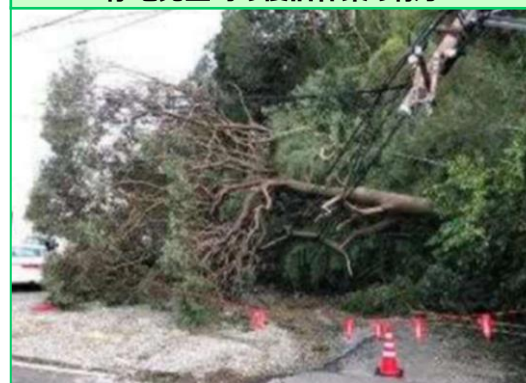
停電発生時の復旧作業の様子
