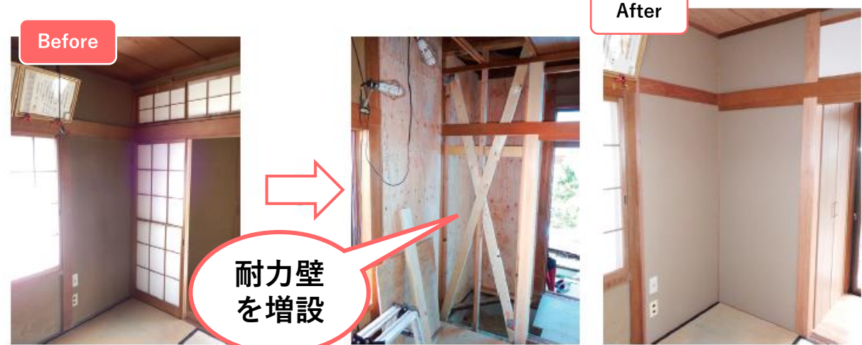
【耐震改修工事の施工例】
