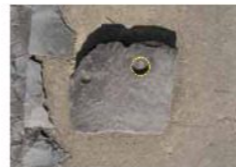
軸摺穴: 径110mm、深さ30mm
