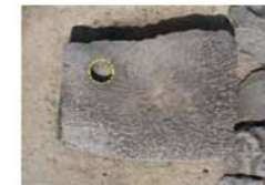
軸摺穴: 径138mm、深さ39mm
