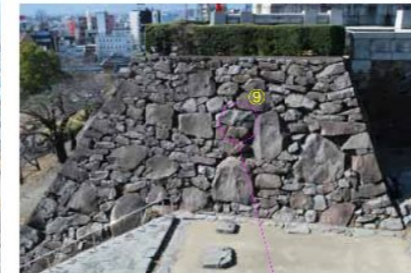
軸摺穴(右): 径140mm、深さ40mm 軸摺穴(左): 径110mm、深さ40mm
