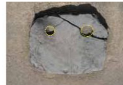
軸摺穴(右): 径140mm、深さ40mm 軸摺穴(左): 径110mm、深さ40mm
