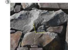
礎柱と⑧の欠込の筋が横わ通っているため、石垣と礎石は同時期のものと推測される。
