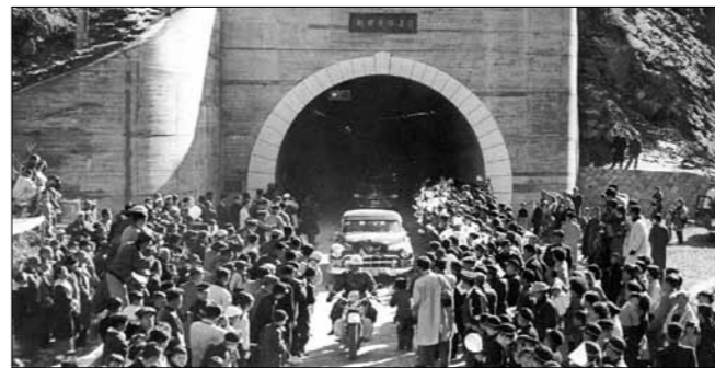
新笹子トンネル開通
