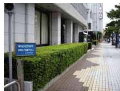
壁面を後退させ前面に緑を配置した景観に配慮した建物
