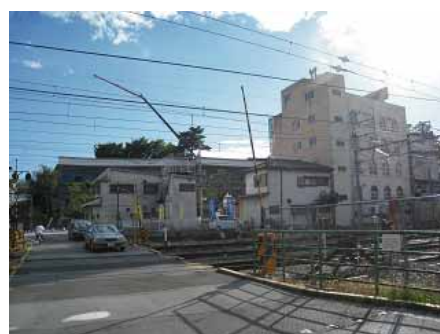
線路北側から見た甲府城
