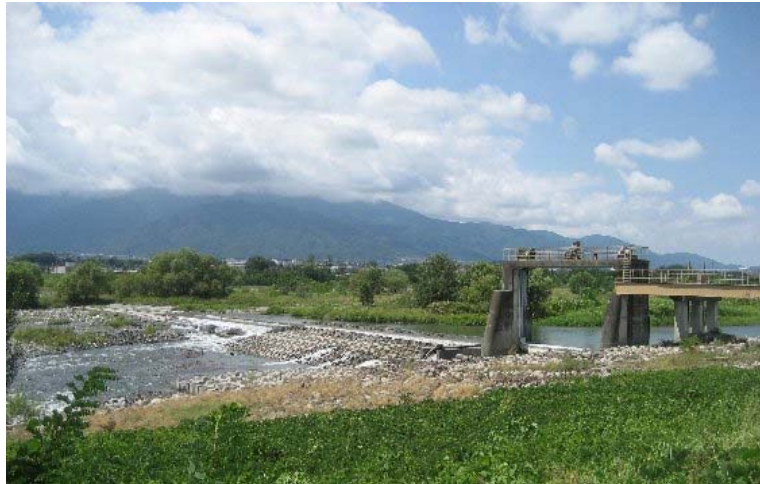
①上堰頭首工の全景。
