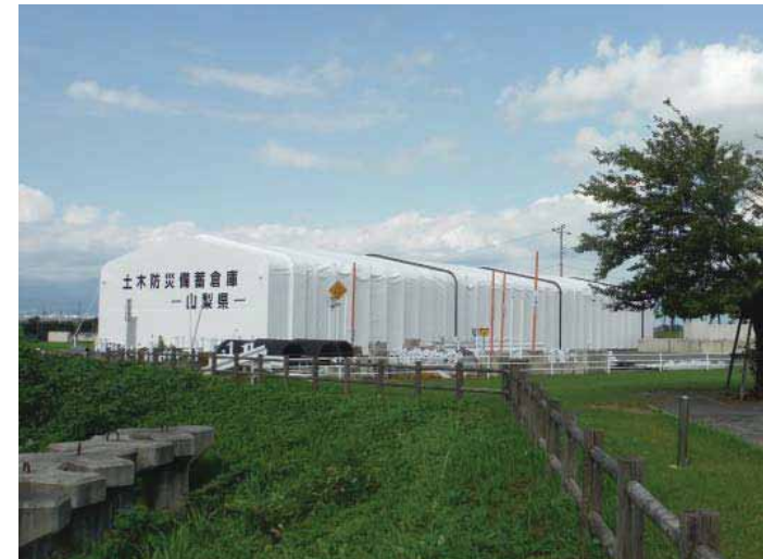
②富士川大橋左岸に位置する 山梨県土木防災備蓄倉庫
