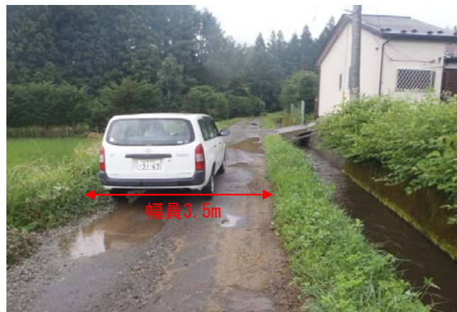
④幅員が狭くすれ違い困難な農道 (市指定緊急輸送路)
