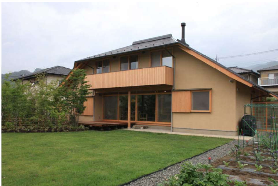
南側からの全景
