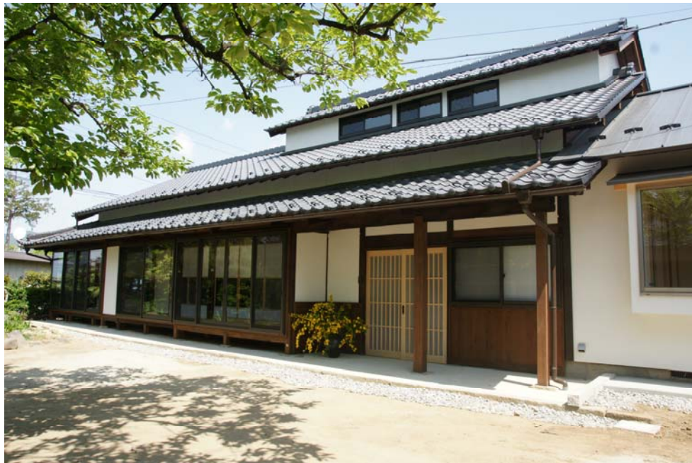
南側からの全景
