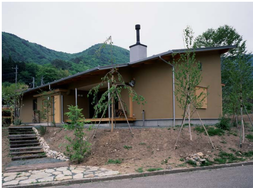
西側からの全景
