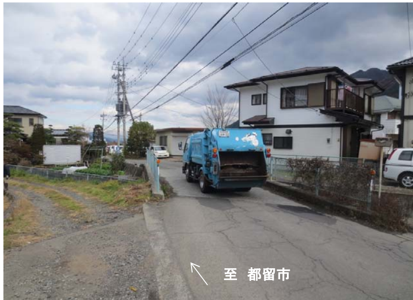
③上暮地工区 現道
