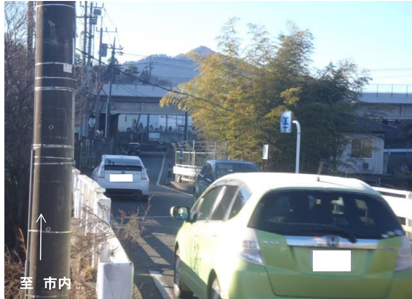
①上暮地工区 笹子橋
