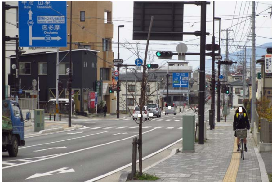
写真① 起点側
