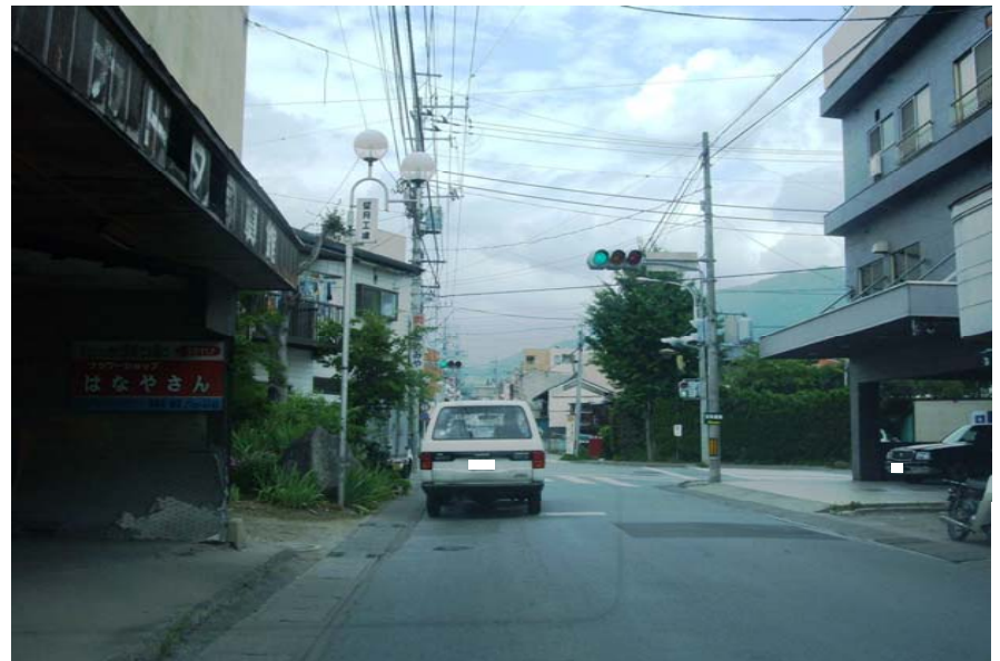
写真④ 着手前(青橋交差点付近)
