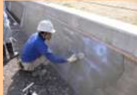
■ 水路の老朽化箇所の補修
