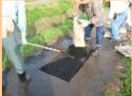
■ 農道舗装の補修
