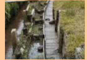
■ 水田魚道の設置
