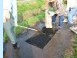
■ 農道舗装の補修
