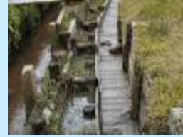
■ 水田魚道の設置
