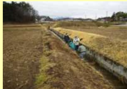
水路の泥上げ
