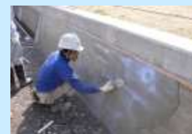
■ 水路の老朽化箇所の補修
