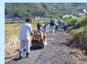
■ 未舗装農道の舗装
