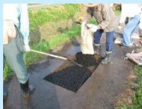
■ 農道舗装の補修
