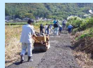
■ 未舗装農道の舗装
