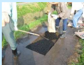
■ 農道舗装の補修
