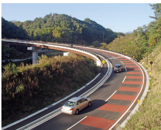
乙坂バイパスの整備により見通しが良くなった北杜八ヶ岳公園線
