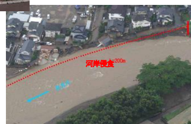
河岸侵食に伴う家屋倒壊等
