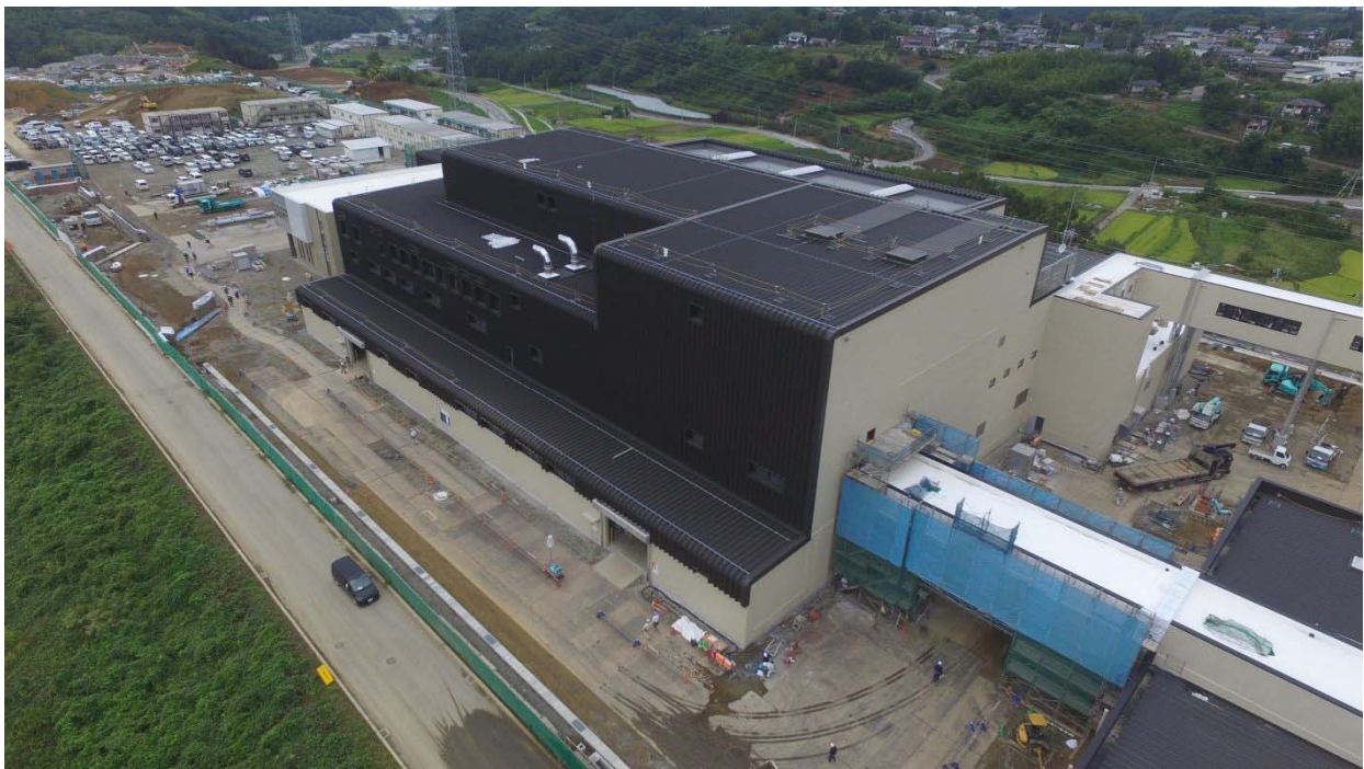
図 2-2-16 (6) ごみ処理施設の工事進捗状況（リサイクル施設 南東側視点） 平成 28 年 9 月時点
