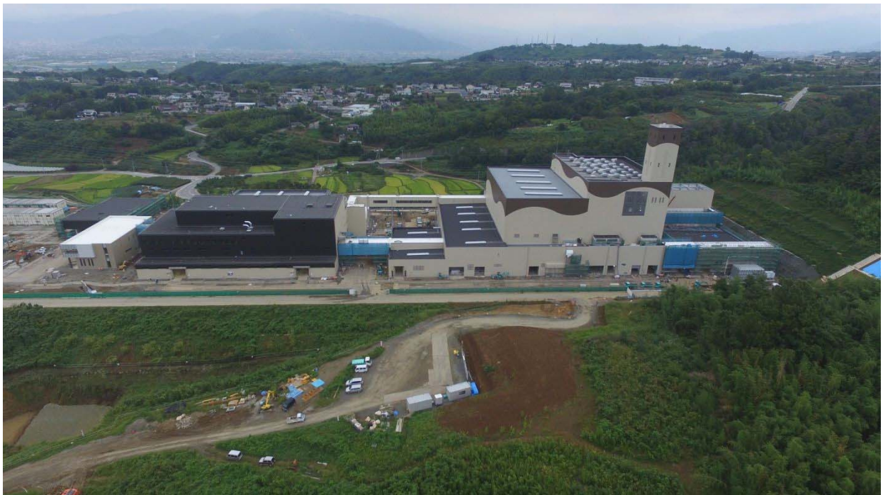
図 2-2-16(4) ごみ処理施設の工事進捗状況（全体 南側視点） 平成 28 年 9 月時点
