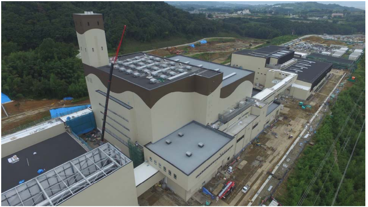
图 2-2-2(4) 現況写真（平成 28 年 9 月撮影）
