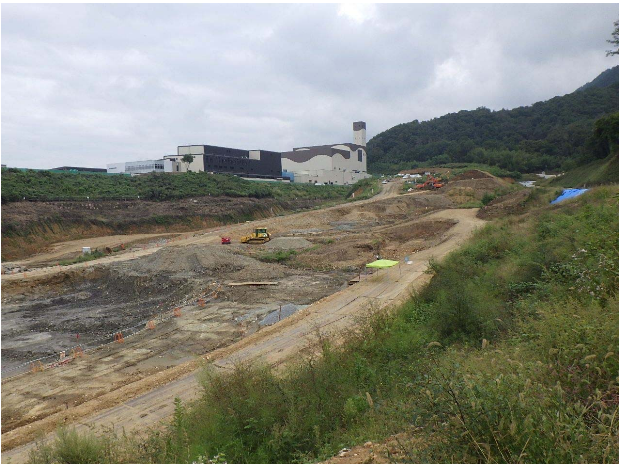
図 2-2-17(2) 最終処分場の工事進捗状況（埋立地 上流側） 平成 28 年 9 月時点
