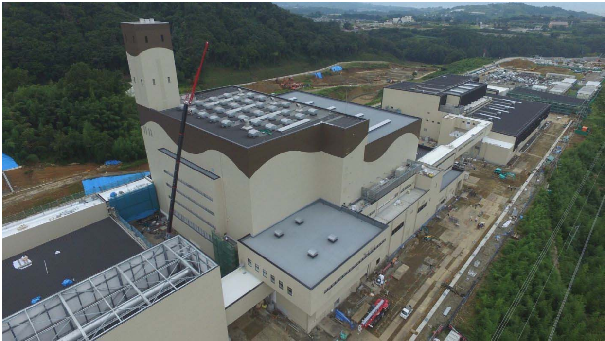
図 2-2-16 (5) ごみ処理施設の工事進捗状況（焼却溶融施設 北東側視点） 平成 28 年 9 月時点
