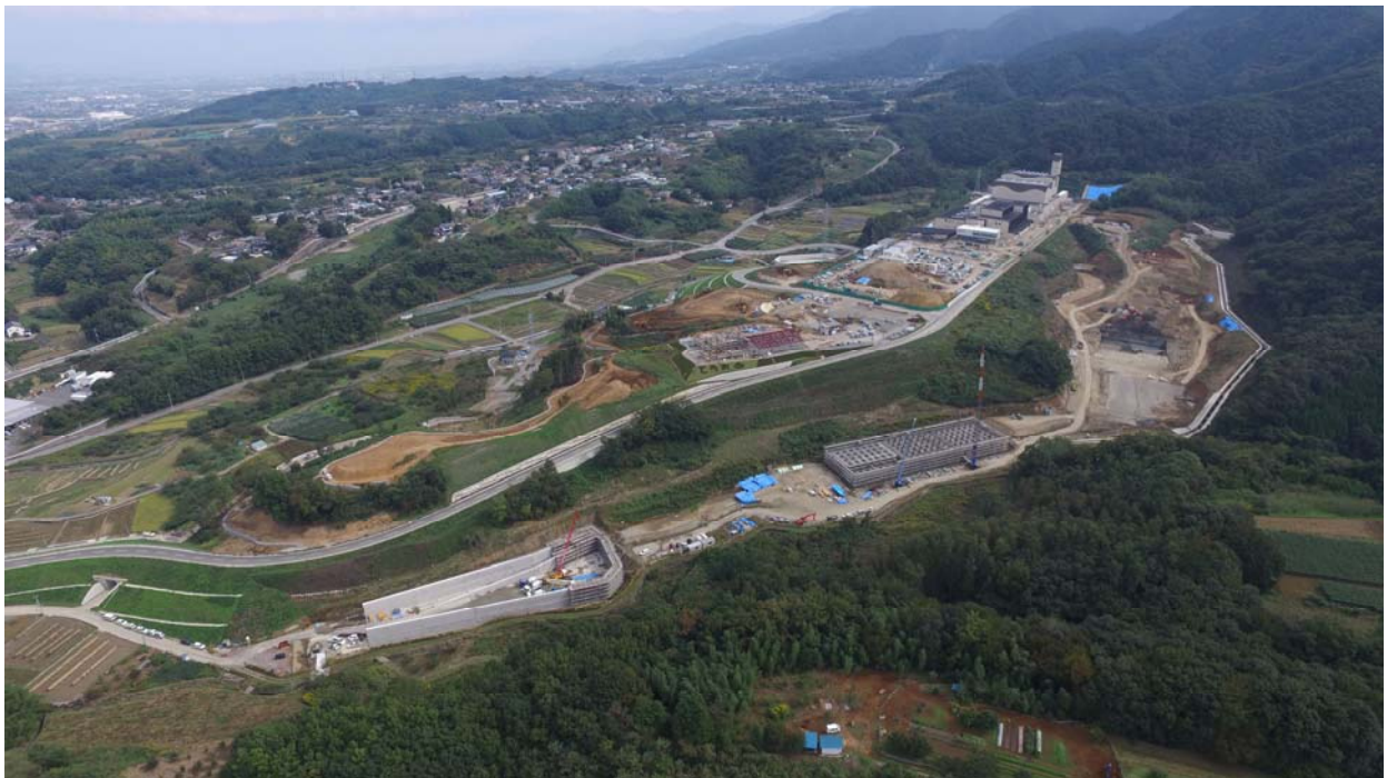
图 2-2-2(5) 現況写真（平成 28 年 10 月撮影）
