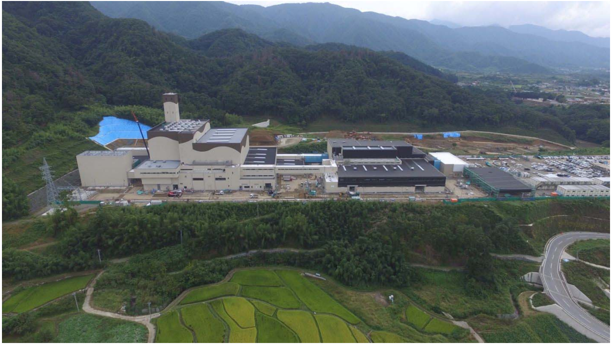
図 2-2-16(3) ごみ処理施設の工事進捗状況（全体 北側視点） 平成 28 年 9 月時点
