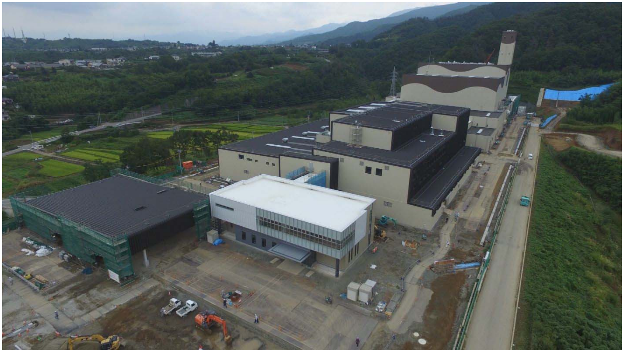
図 2-2-16(2) ごみ処理施設の工事進捗状況（全体 西側視点） 平成 28 年 9 月時点
