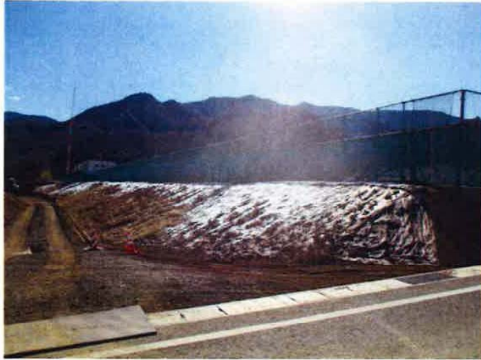
仮設工事 北面仮囲い設置状況 H2000-3000 メッシュシート
