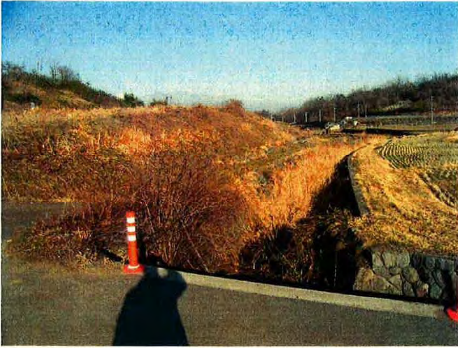
甲府・峡東地域ごみ処理施設造成工事 (調整池)
