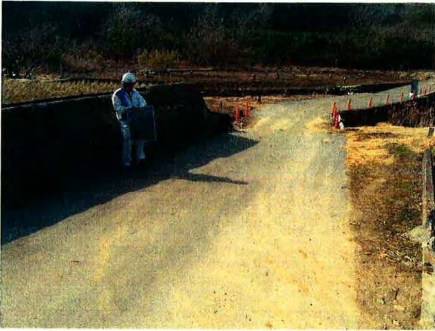
甲府・峡東地域ごみ処理施設造成工事 (調整池)
