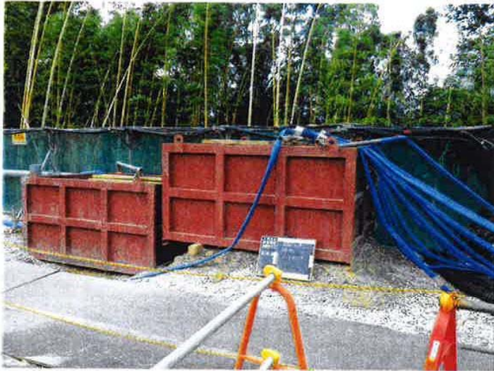
仮設工事 仮設ノッチタンク 設置 施工完了
