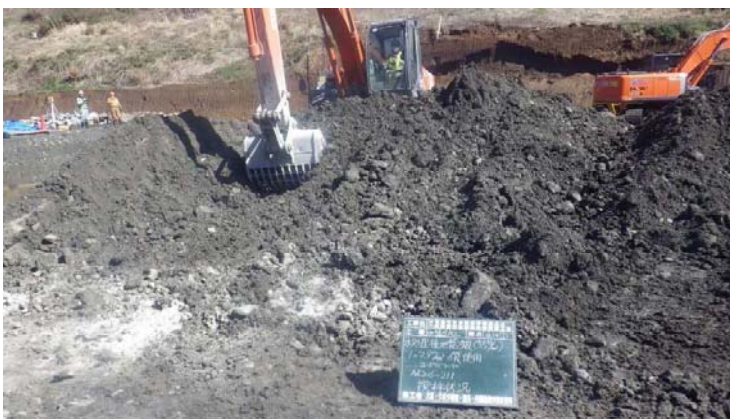
写真 バックホウ混合（攪拌状況）
