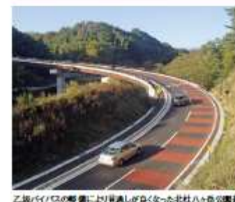
乙坂バイパスの整備により見通しが良くなった北杜市八ヶ岳公園線
