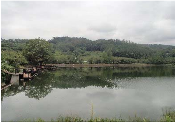
① ため池の全景
