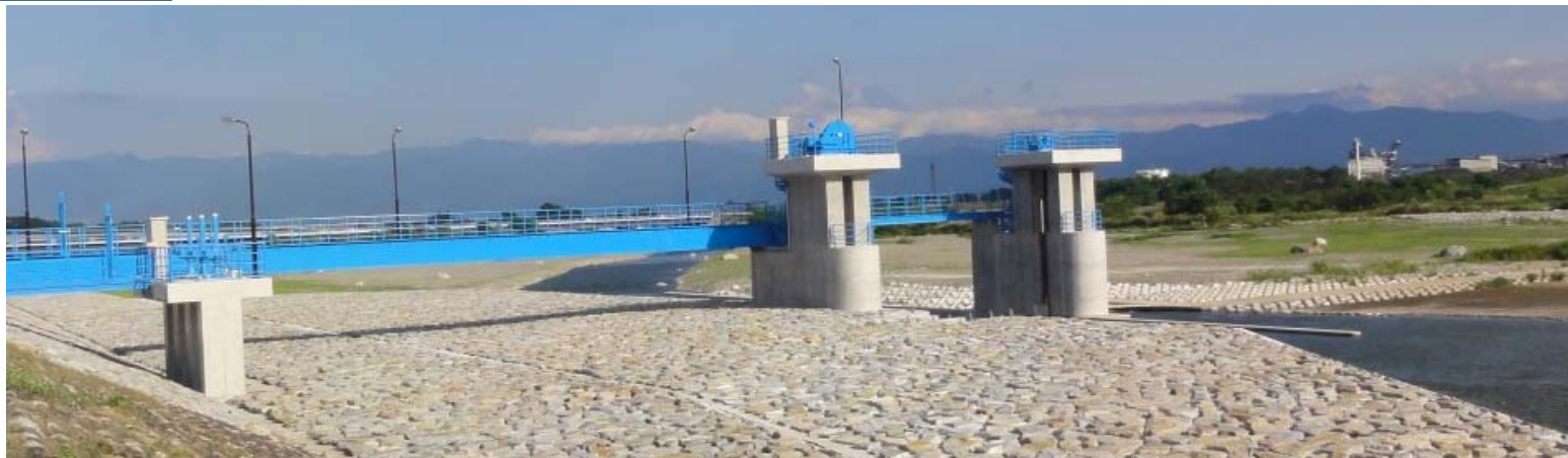
老朽化した取水施設を改修し、安定した農業用水の供給が可能になっている。
