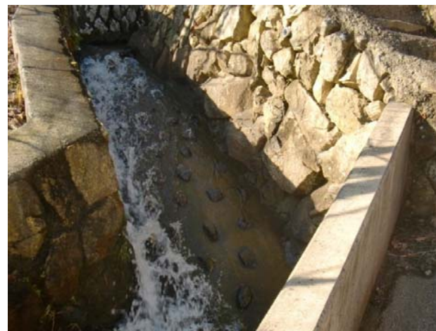
完成後 水路整備により流下能力が高まり、洗掘の恐れや溢水による被害が解消されている。
