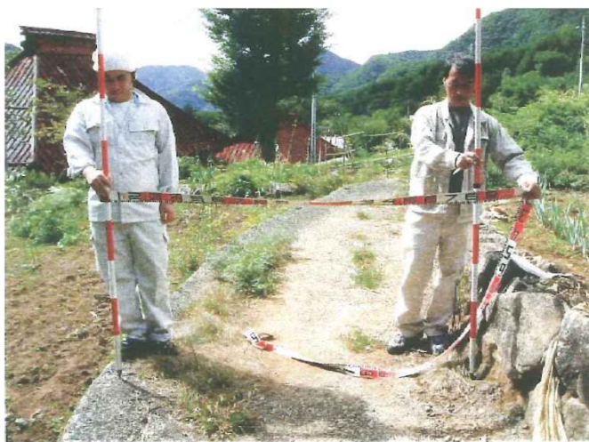
着工前 幅員が狭く、未整備区間もあり、農機具の搬入や脱輪の危険など通作に支障をきたしていた。
