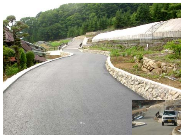
完成後 農道の整備により、農耕車が容易に進入できると共に、すれ違いが可能となるなど、安全性と農作業の利便性が向上している。
