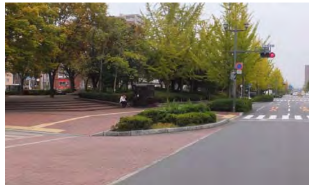
写真 3.11 道路と一体的に景観的に配慮された公園 道路空間の再配分に辺り、並行する河川や公園と一体で検討が実施され、意匠の統一が図られている。
