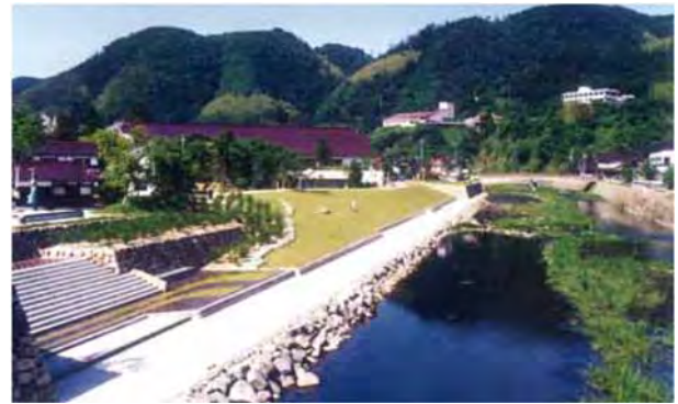
写真 3.9 堤内側に引き込んだ広場を設けた河川 通常の河川区域内の概念にとらわれず、まちの中へ河川空間を引込み、川沿いにおける憩いのスペースが創出された。 ※参考文献 3-8 より (島根・津和野川)
