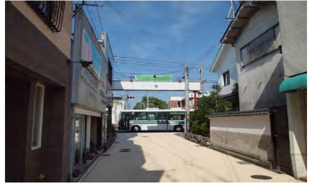
写真 3.20 色だけを合わせたカラー舗装
