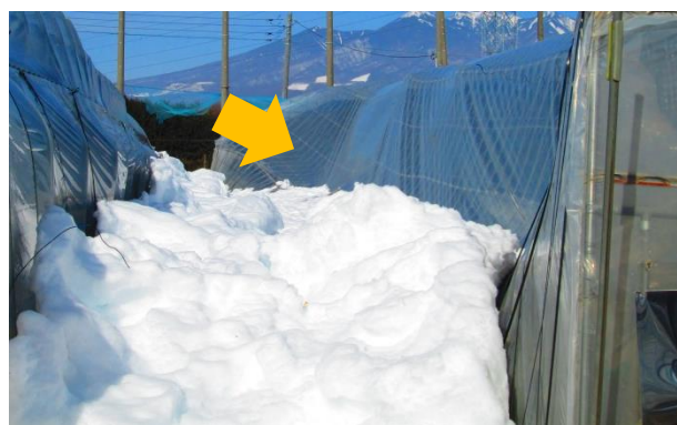
②側圧による被害
