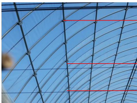
針金を使用した補強例
