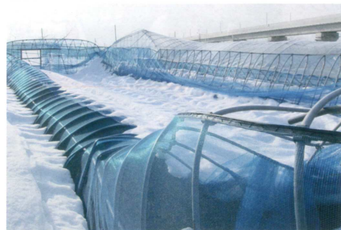
パイプハウス屋根の陥没
