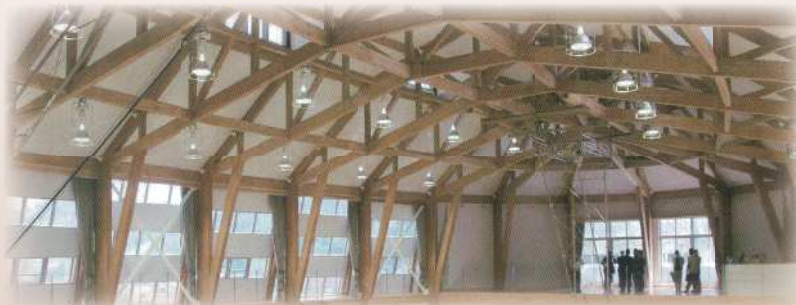
LVL を使った建築物 (小菅体育館)
