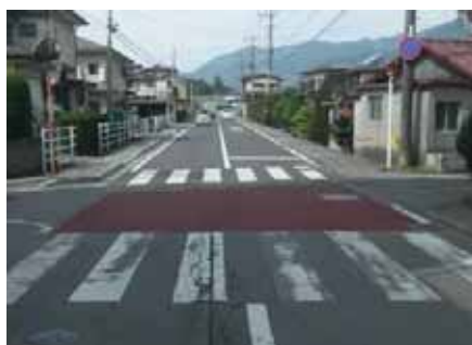
ドライバーへの注意喚起 (グリーンベルト、カラー舗装)
