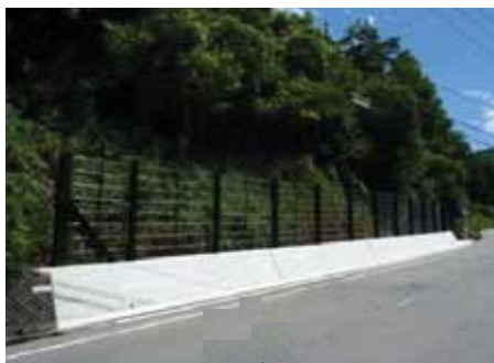
落石防護柵工
