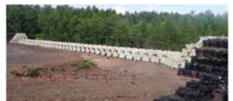
■ブロック堰堤緊急施工事例(浅間山)
