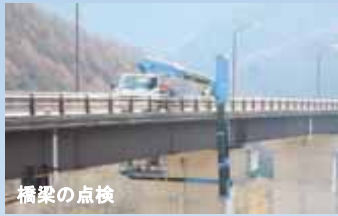
■インフラの長寿命化に向けた点検の様子
