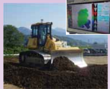
■MGブルドーザによるICT施工
