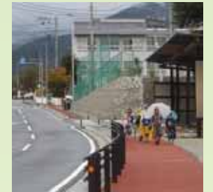
■安全対策が実施された通学路
