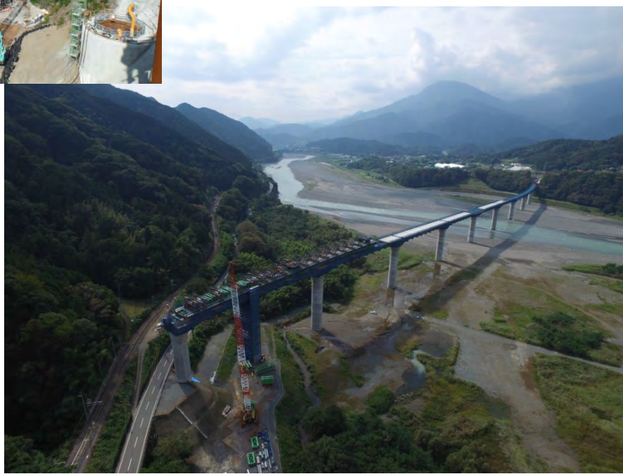
「中部横断自動車道 富士川橋」 平成27年9月29日撮影
