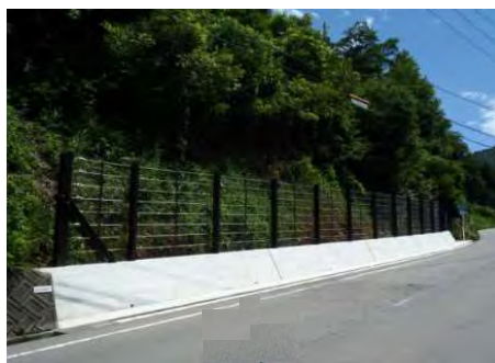
落石防護柵工
