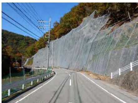
落石防護網工
