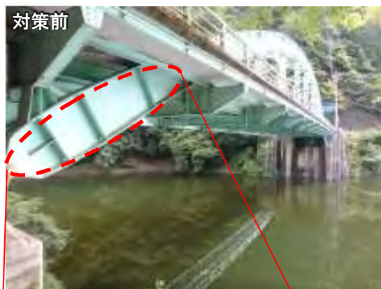
■緊急輸送道路の耐震補強の例・ 落橋防止対策(国道411号 鴨沢橋)
