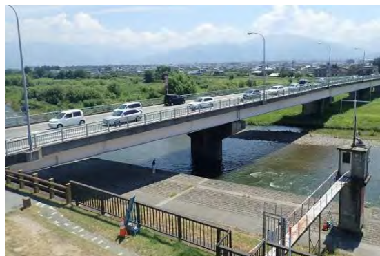
■耐震補強工事実施予定箇所 (消防本部と接続する(一)石和温泉停車場線 鶺鴒橋)
