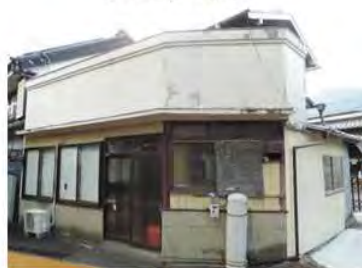
空き家の除却
