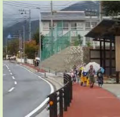
■安全対策が実施された通学路
