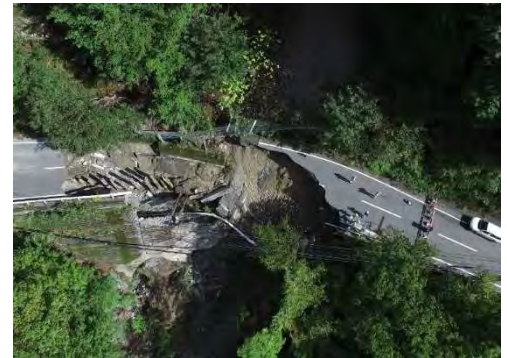
(主)南アルプス公園線(早川町湯島)
