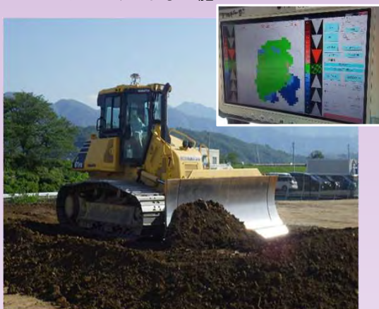
■MGブルドーザによるICT施工
