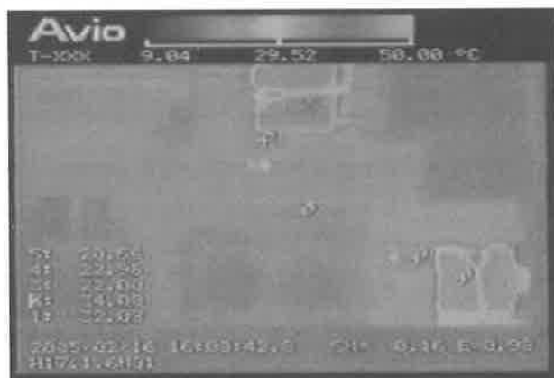
図6 サーモグラフィーの画像(熱対策後)
