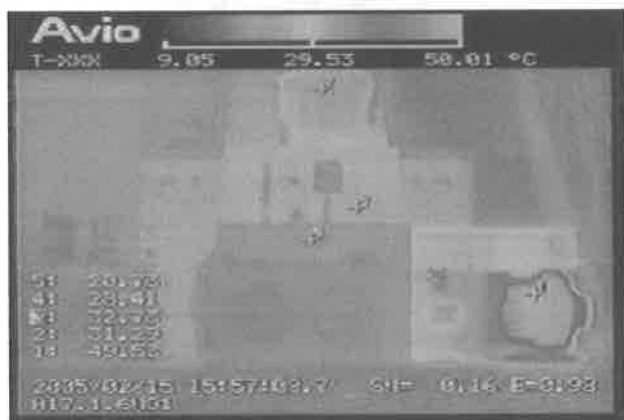
図5 サーモグラフィーの画像(熱対策前)
