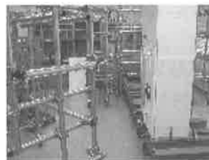
写真12 タワーの設置
