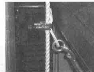
写真32 ロープと戸のつながり
