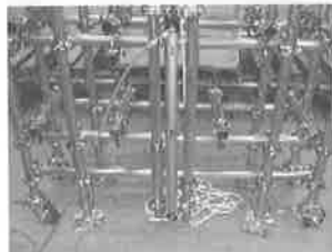
写真20 エアシリンダーの取付
