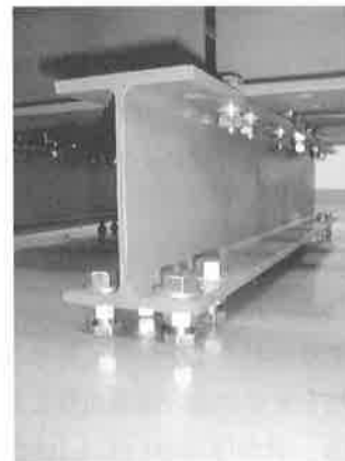
写真7 1段目H形鋼下面の高さ調整機構
