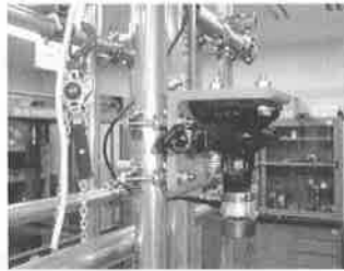
写真23 パンタグラフジャッキの取り付け方法2
