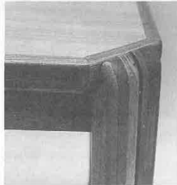
写真12 ダイニングテーブル脚取付部の納まり
