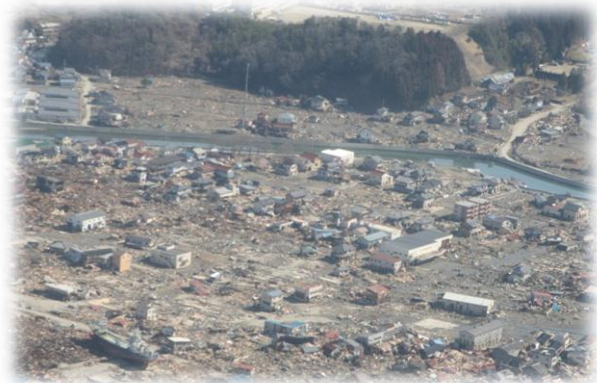
津波により被災した街の様子
