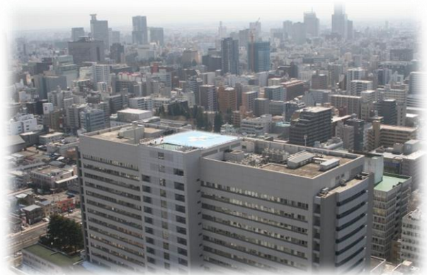
東北大医学部病院屋上ヘリポート
