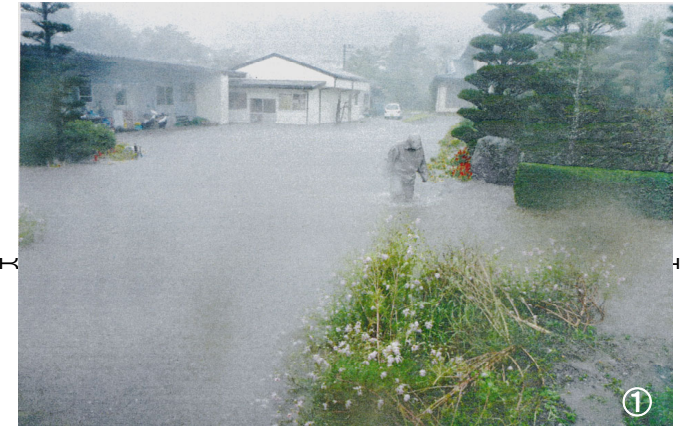
溢水状況 H23.9.21 (台風15号)
