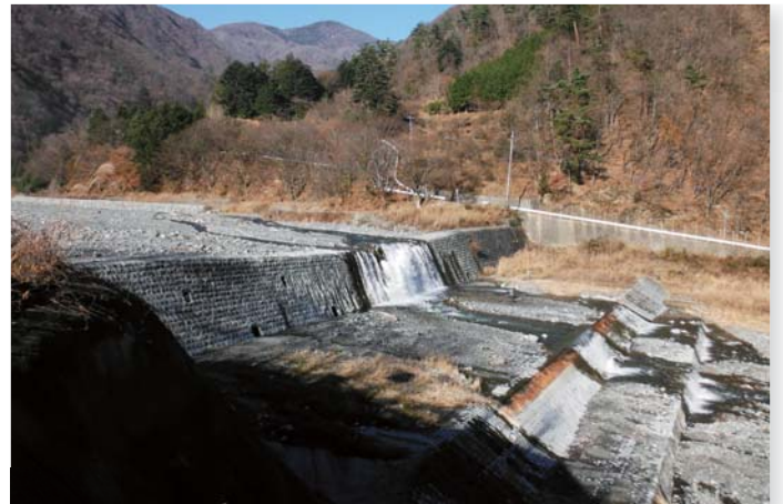
■源堰堤（南アルプス市芦安芦倉）
