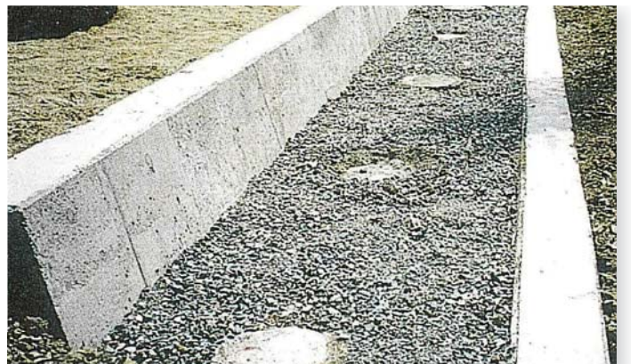
■鋼管杭工（身延町伊沼）
