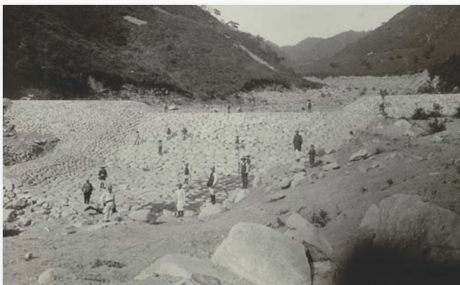
■明治43年屋敷入沢第7号砂防堰堤（御坂町：現笛吹市）
