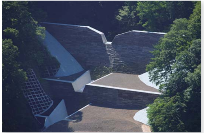
■ 金山沢堰堤（金山沢、南アルプス市駒場）
