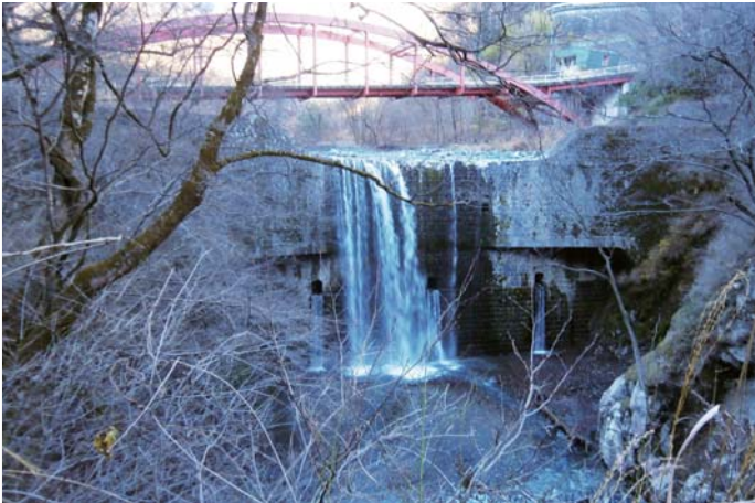
■芦安堰堤（南アルプス市芦安芦倉）
