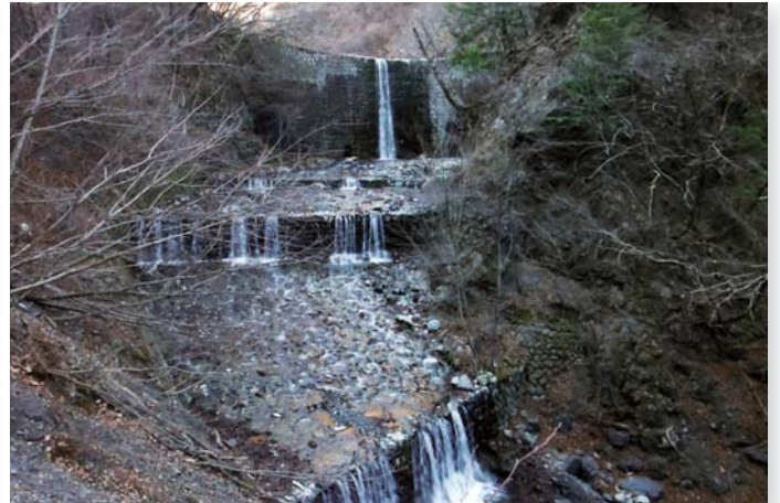
■藤尾堰堤（南アルプス市芦安安通）
