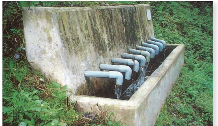
■横ボーリング工（小菅村小永田）
