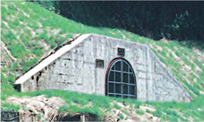
■排水トンネル工（富士川町西沢）
