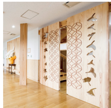
エントランスホールにあるCLT。穴をあけても強度がある。図柄デザインは学生たちが考案した
