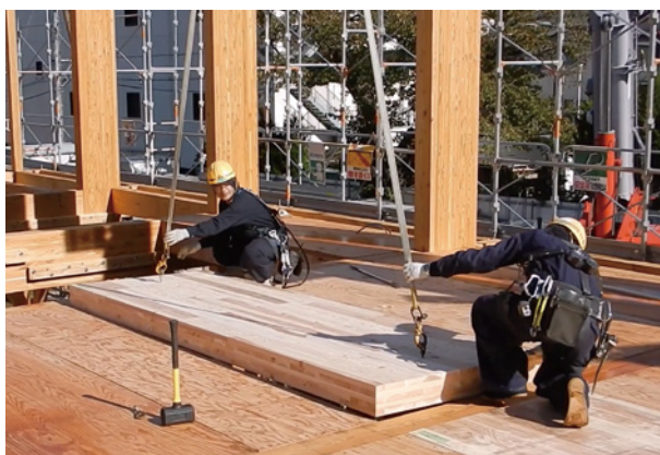
エントランスホールではパネル展示などとともに、建設工事の様子を動画で流し、訪れる方などに広く紹介している
