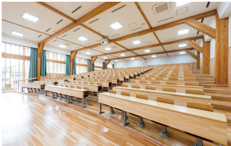
大講堂「岩殿ホール」の柱、梁などの構造部材にも、木材を使用している
