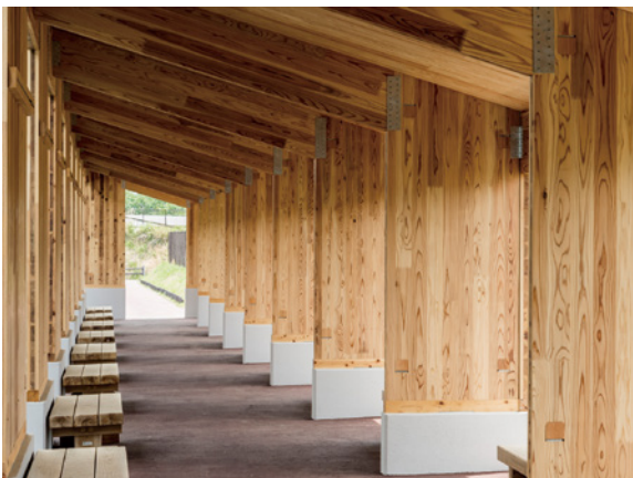
休憩施設内部には、木製ベンチ20脚を設置
