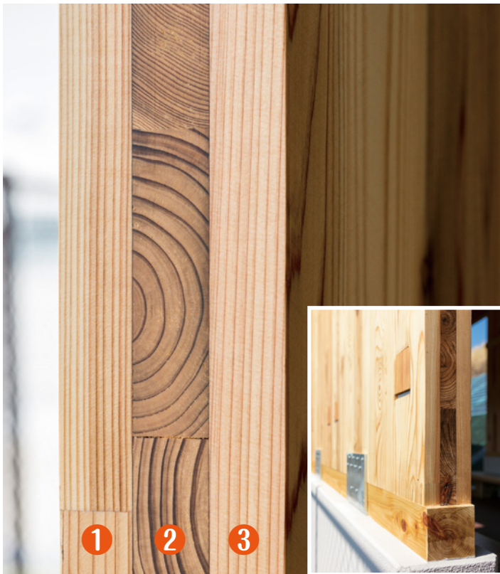
県産スギを3層にしたCLT、厚さは9センチメートル。屋外休憩施設「サンシェードテラス」では、壁に使用している
