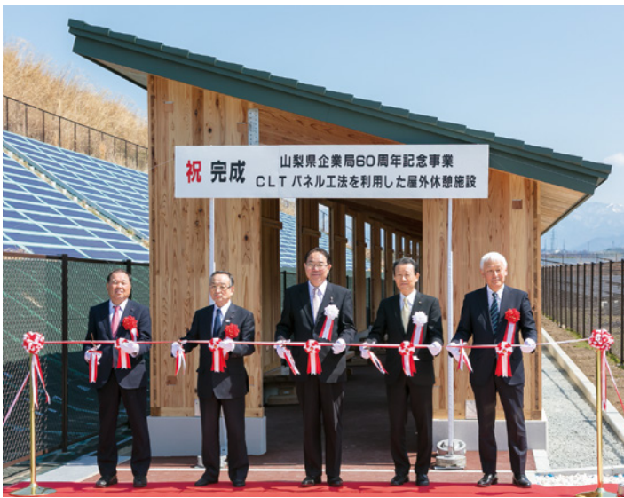
3月28日に行なった、CLT工法を活用した屋外休憩施設「サンシェードテラス」の完成式
