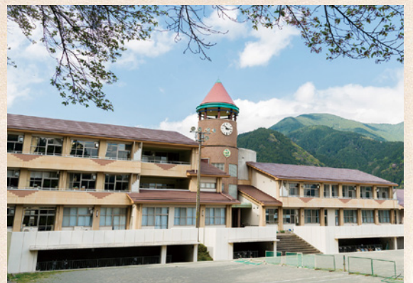
「蒙軒学舎」の名を冠した、南部町立南部中学校
