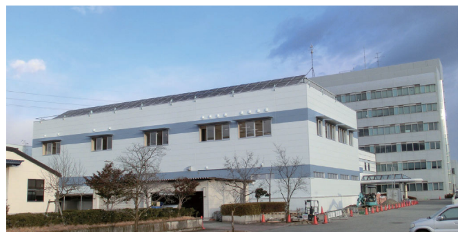
工事中の新棟(産業技術センター 甲府技術支援センター)
