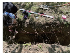
土壌調査の様子
