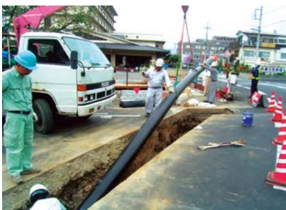
配湯管敷設替工事風景
